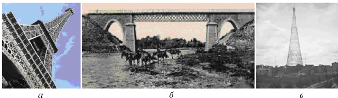
Рисунок 8 – Снимки стержневых конструкций с перекрестными решетками Эйфелевой башни, 1889 г. (а), железнодорожного моста в Кисловодске, 1894 г. (б), Шуховской башни на Шаболовке, 1920 г. (в) Figure 8 – Photographs of rod structures with cross gratings of the Eiffel Tower, 1889 (a), the railway bridge in Kislovodsk, 1894 (b), the Shukhov Tower on Shabolovka, 1920 (c)
