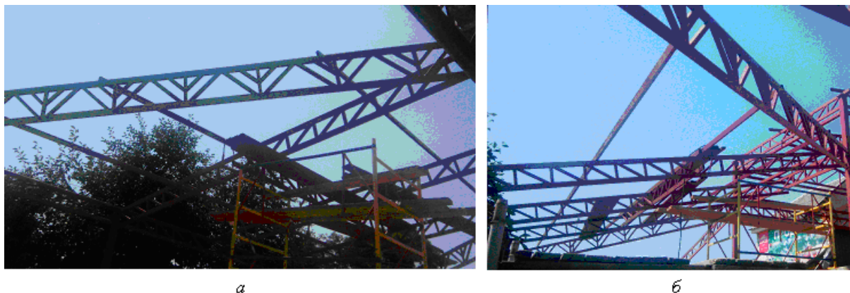
Рисунок 4 – Снимки ферм покрытия с параллельными поясами и Ψ-образными стойками решеток диагонального направления (а) и ортогонального направления (б)
