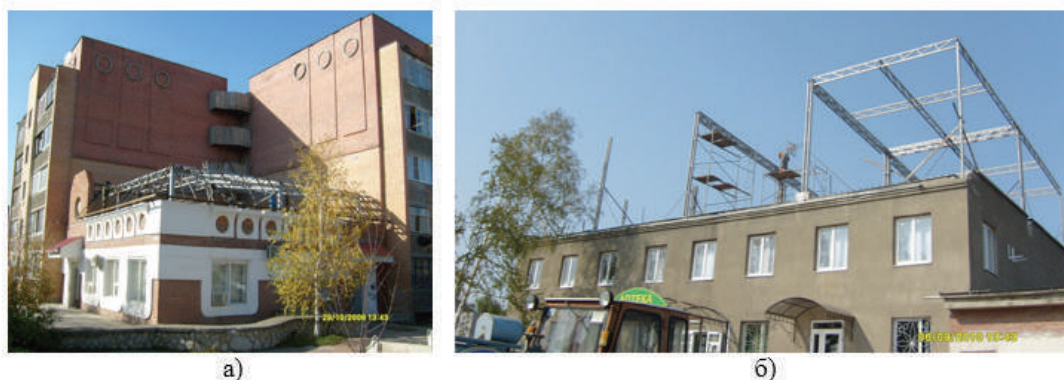
Рис. 2. Снимки реконструкции одноэтажного здания с ГВЭ из 4 блоков 5 \times 5 м (а) и двухэтажного здания с ГВЭ из 8 блоков 6 \times 6 м (б)
