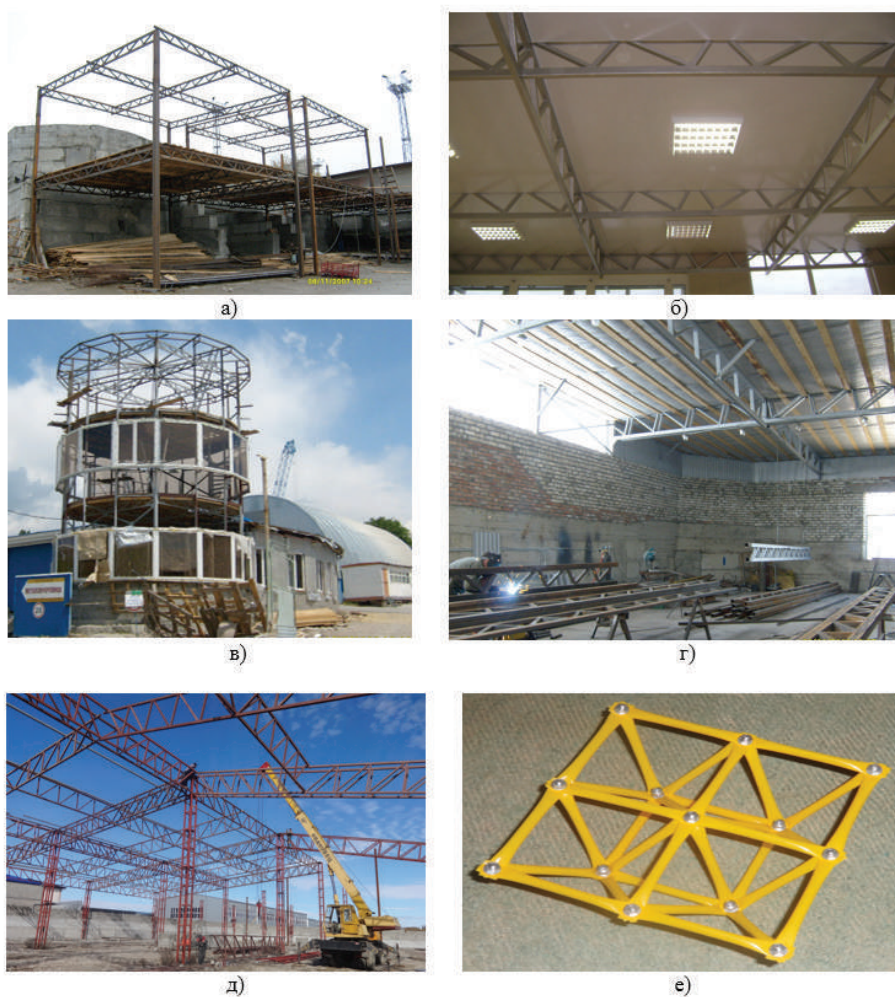
Рис. 3. Снимки двухэтажных модулей (а), блока перекрытия в интерьере офисного здания (б), трехэтажного модуля (в), цеха по изготовлению перекрестных ферм (г), монтажа модулей покрытия (д) и фрагмента конструкции с использованием пространственного решетчатого узла перекрестных ферм типа «Новокисловодск» (е)
