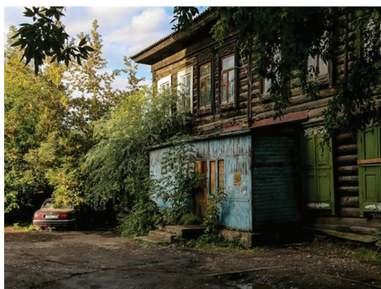
Рис. 6 Задний двор исторического здания (современное состояние)
