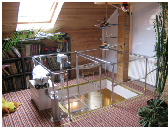
Рис. 4. Подъемные устройства внутри здания
