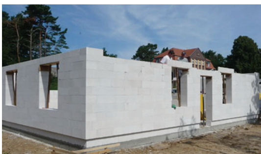
Рис. 3. Строительство жилого дома из газосиликатных блоков
