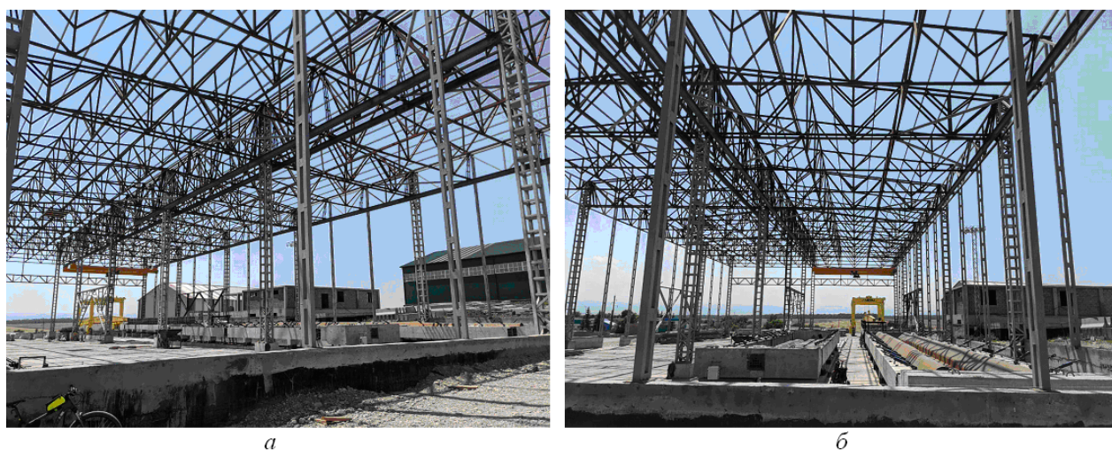
Рисунок 6 – Снимки монтажа каркаса промышленного здания с 10-тонными подвесными кранами в г. Лермонтов из перекрестных стальных ферм типа «Пятигорск» [21] с Ψ-образными стойками в треугольных решетках: виды боковой (а) и фронтальный (б)
