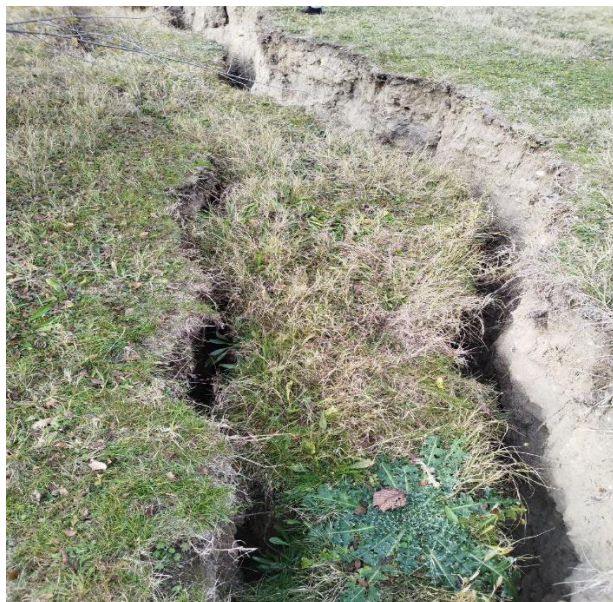
Рисунок 6 – Глубокая береговая эрозия Figure 6 – Deep coastal erosion
