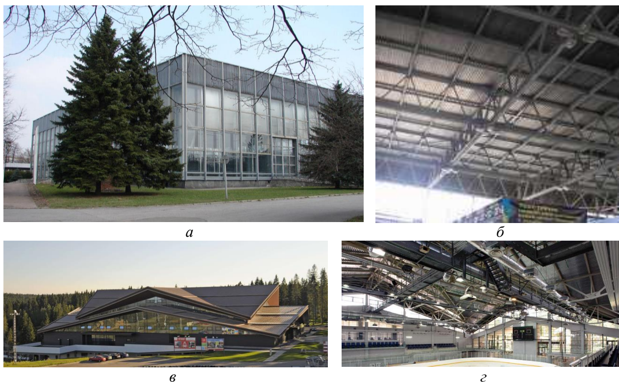
Рисунок 1. Снимки павильона «Механизация сельского хозяйства» в Киеве (а) и ортогональной системы перекрестных ферм стальных из парных уголков его покрытия (б), а также ледовой арены в 50 км от Санкт-Петербурга (в) и ортогональной системы перекрестных стальных ферм из прямоугольных труб ее покрытия (г)
