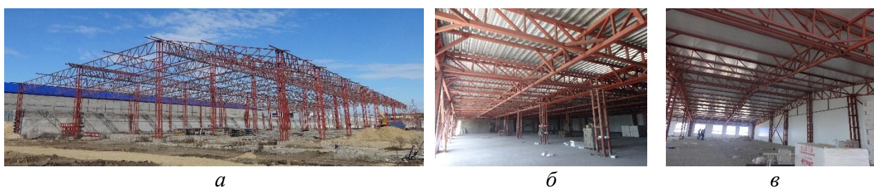
Рисунок 2. Снимки общего вида нового строительства (а), а также модулей 7 \times 7 м его перекрытия (б) и модулей 14 \times 14 м покрытия (в)
