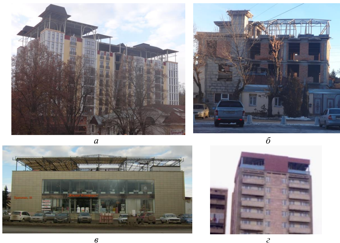
Рисунок 4. Снимки зданий с гибкими верхними этажами в Кисловодске (а, б), Пятигорске (в) и Ванадзоре, Армения ( г) / Fig. 4. Photos of buildings with flexible upper floors in Kislovodsk ( a , b ), Pyatigorsk ( c ) and Vanadzor (Armenia, d )
