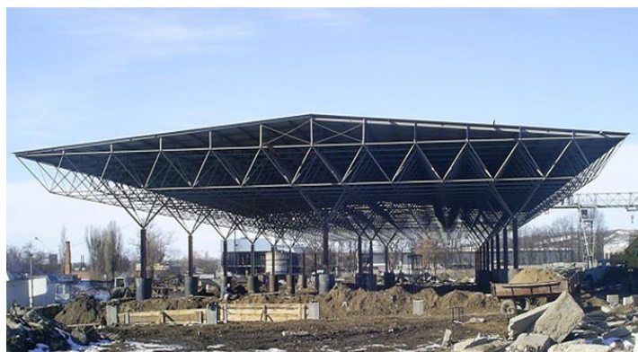
Рис. 4. Общий вид конструкций на станции Скачки (год изготовления – 1966, год повторного применения – 2005)
